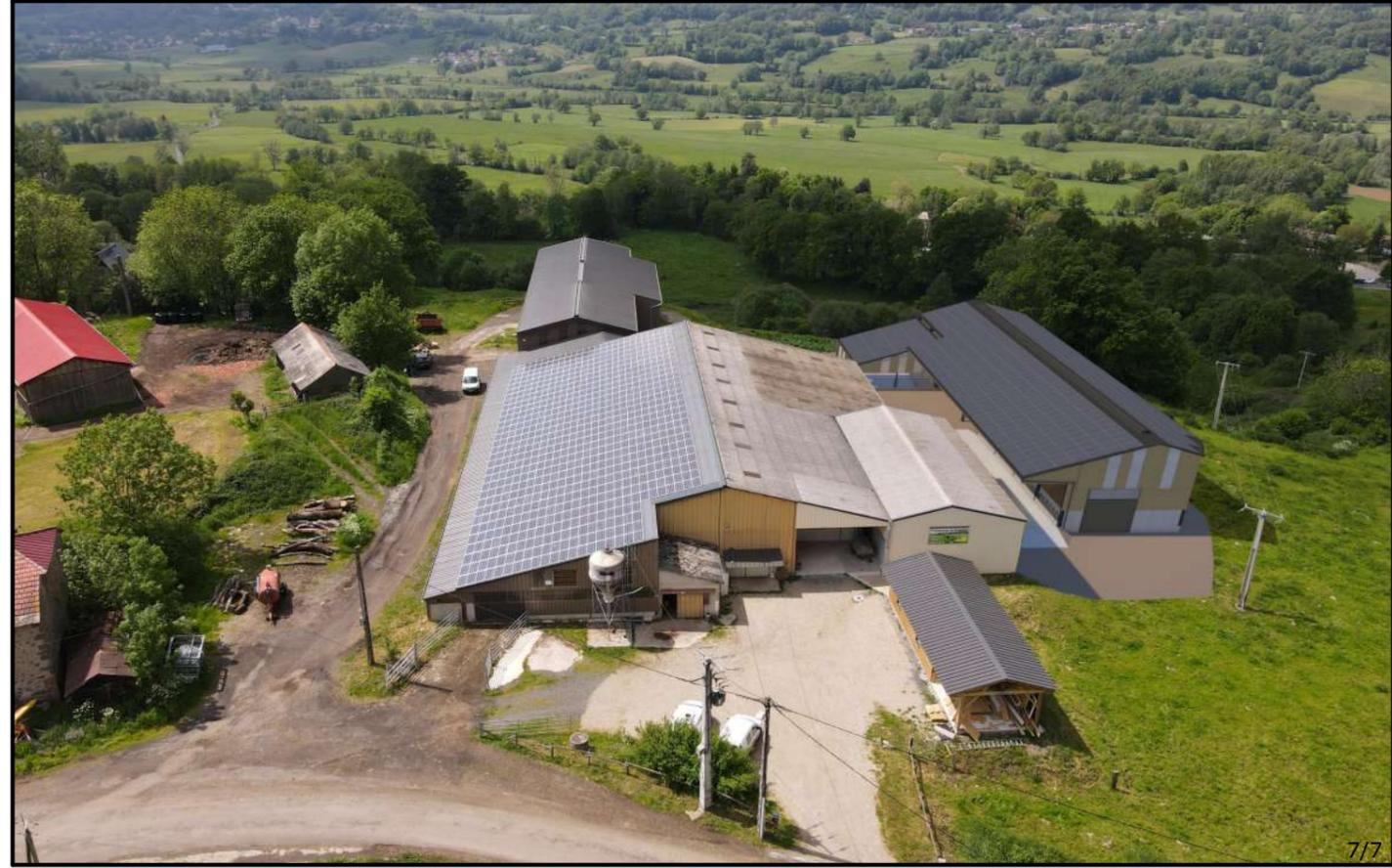
**Projet:** Un hangar métallique semi-ouvert avec couverture photovoltaïque à usage de stabulation bovins, stockage fourrage et fumière couverte.
