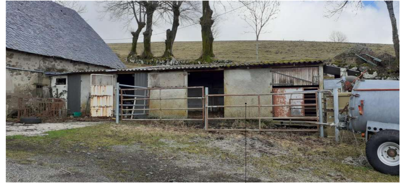
Bâtiment 3 à démolir : loges. Surface : 45.44 m 2 .
