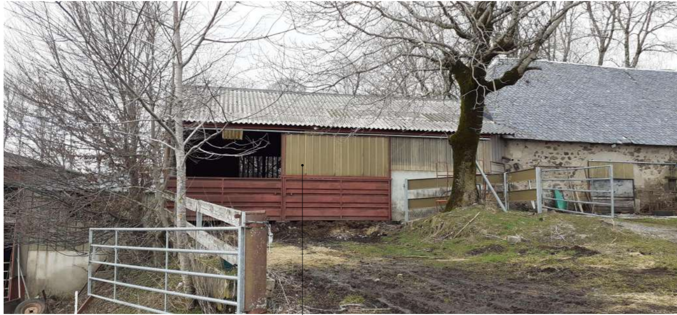
Bâtiment 1 à démolir : stabulation broutards. Surface : 138.20 m 2 .
